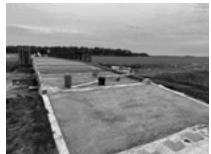
Laatste werkzaamheden door de dienst Openbare Werken: aanleg van de op- en afrit.
